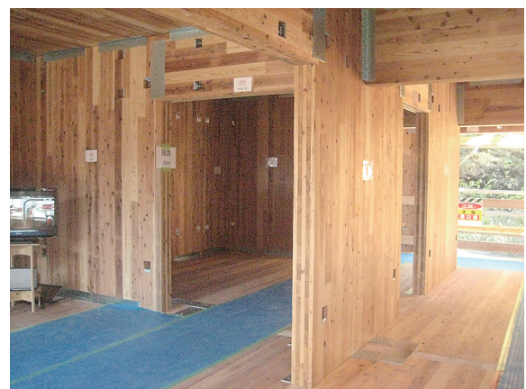
写真1 CLTによる躯体
