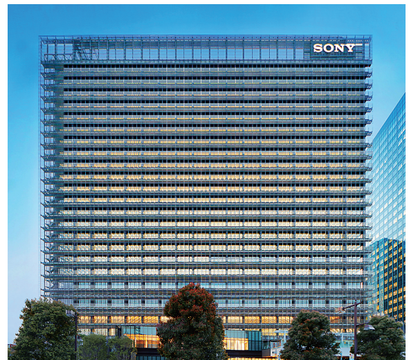
図9 各種センサーを組み込み、雨水を用いてファサードを冷やし、ヒートアイランドを抑制する、最初期のIoTファサード「バイオスキン」の例（NBF大崎ビル／日建設計 2011年）
