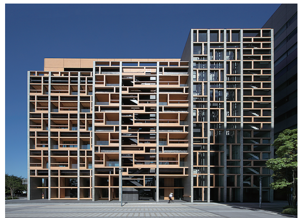
図7 完成した外観（木材会館/日建設計 2009年）
