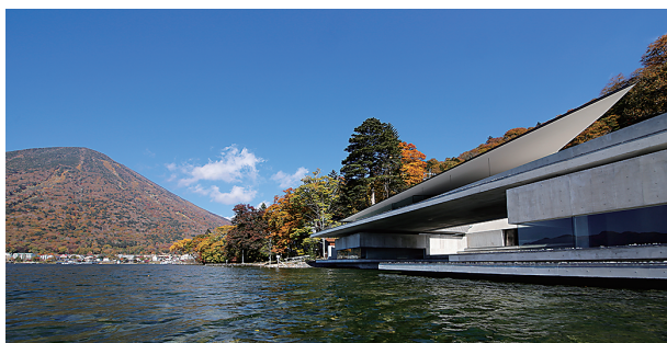
図2 完成した住宅 (On the water/日建設計 2015年)
