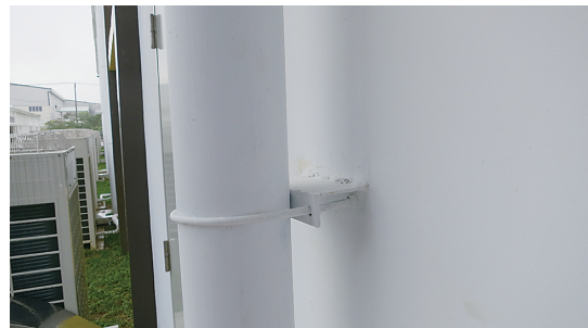
写真2 縦樋の支持の仕方
