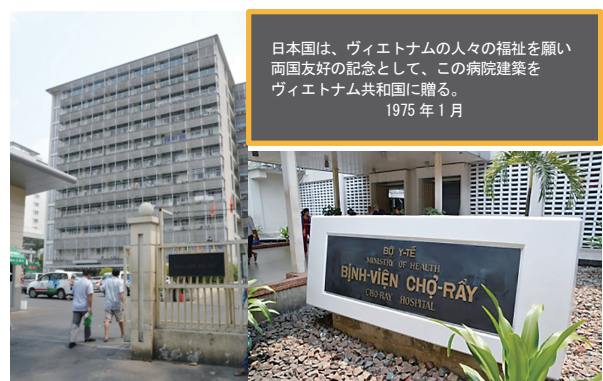
写真6 国立チョーライ病院（CRH）の高層病棟と玄関付近 風通しのよい中空コンクリートブロック外壁が特徴（右下写真奥）。右上の内容の銘板はこの玄関に入って左側にあった。1995-1999にはJICA技術協力で改修工事が実施された。JICA円借款事業により1,000床規模のチョーライ第二病院整備事業（レミンシャン工業団地内）が進行中。
