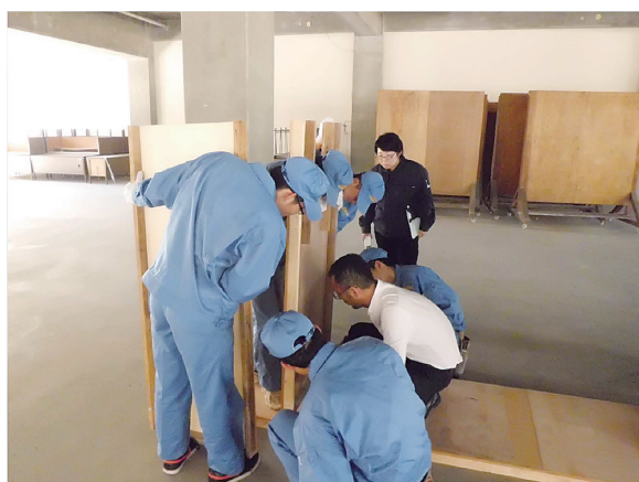
写真7 出張教育の実施（型枠実技）
