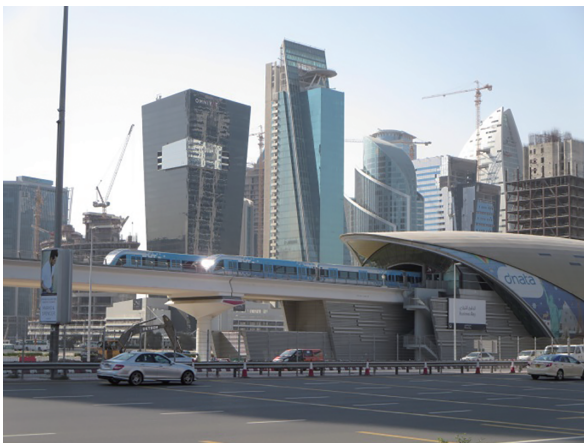
写真2 ドバイメトロと建物群 手前は自動車道路
