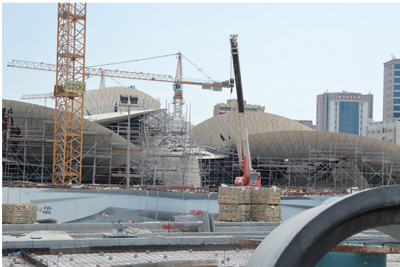
写真1 ドー八市内で建設中の国立美術館
