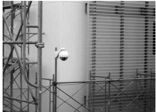
写真3 現場内に設置された WEB カメラ
