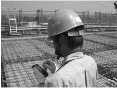
写真1 配筋検査支援システムの利用状況
