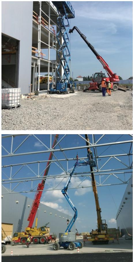
写真7 大型の高所作業車
