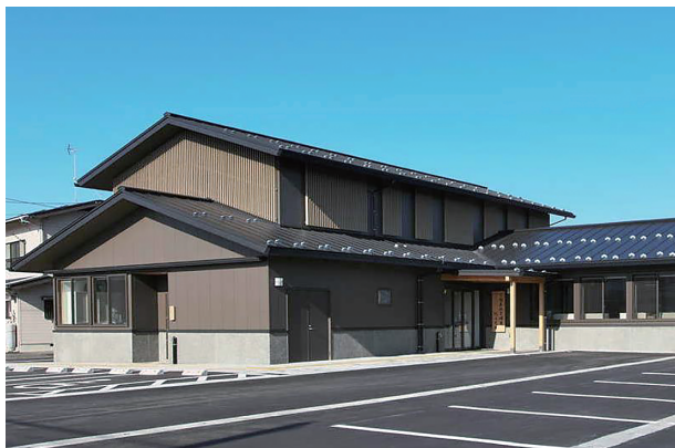
写真1 下越森林管理署村上支署（木造化）
