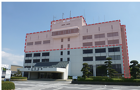
写真2 旧庁舎減築範囲（点線内減築部分）
