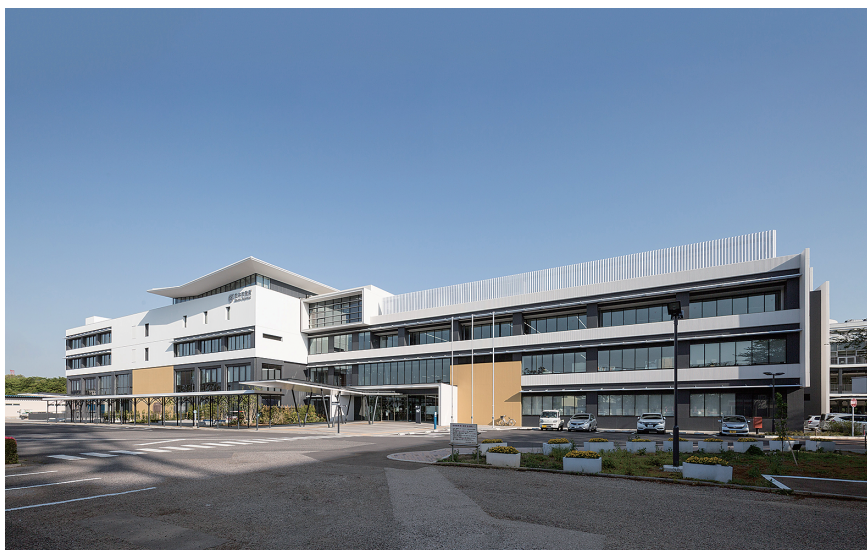
写真4 完成写真（左に減築改修棟、中央部新築棟、右奥に保健福祉センター）
