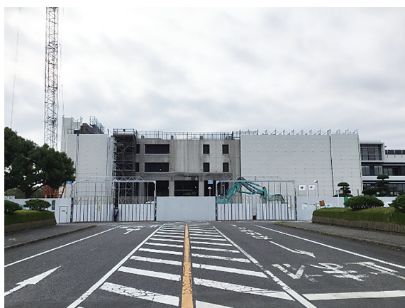
写真3 減築工事の状況
