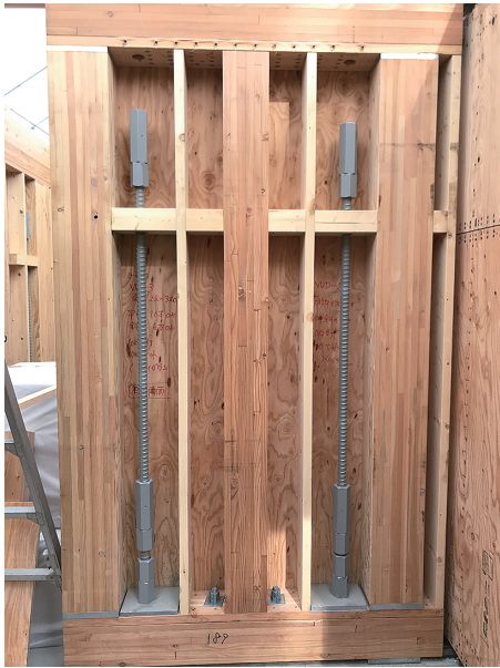
写真3 拡張型SSW14工法耐力壁施工状況
