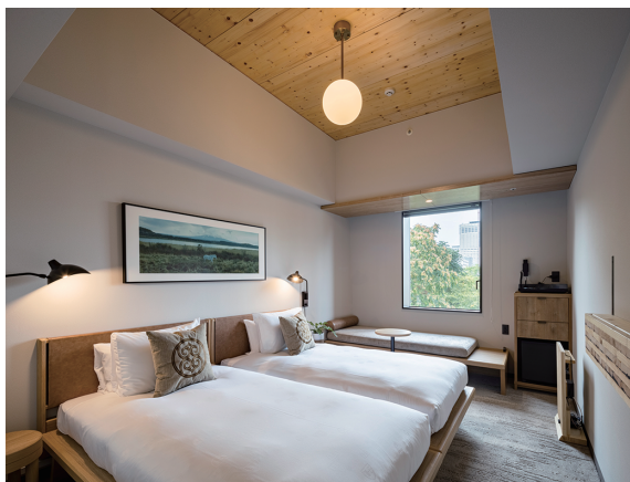
写真2 RC階客室（「配筋付き製材型枠」による木質化）
