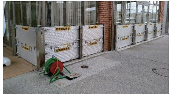
写真11 近隣河川増水時に設置された止水板
