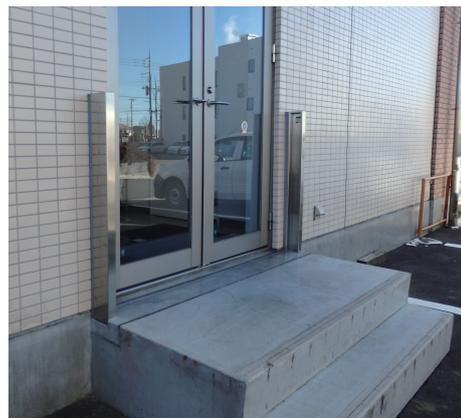
写真12 止水板を取り付ける支柱を設置
