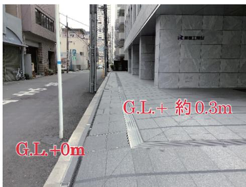
写真3 建物1階床面の嵩上げ(a)
