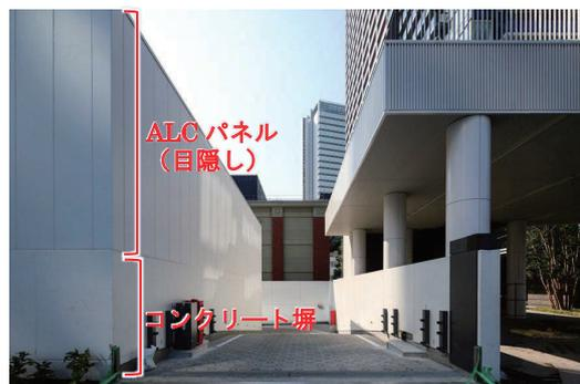
写真5 電気設備周囲の塀（外観）
