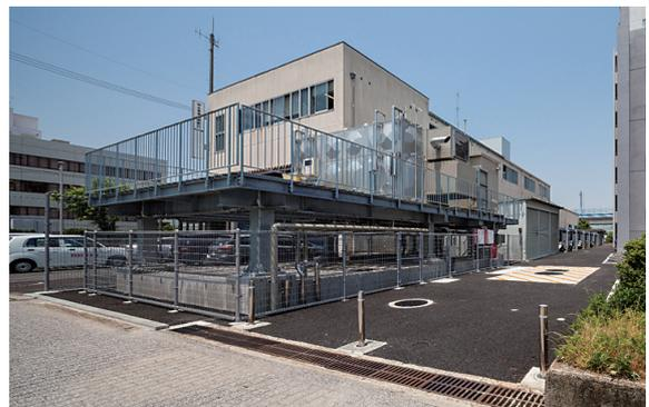
写真2 浸水対策として非常用発電機及び受水槽を屋外に新設した架台上に移設した事例（広島港湾合同庁舎（広島県））
