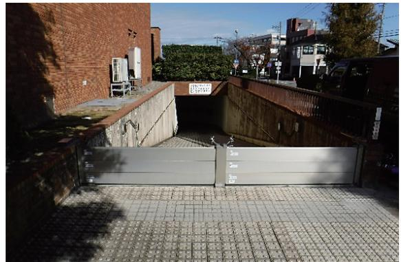
写真1 水防設備（止水板）の設置事例（左：東雲地方合同庁舎（東京都）、右：金沢新神田地方合同庁舎（石川県））
