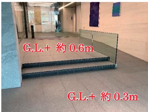
写真4 建物1階床面の嵩上げ(b)
