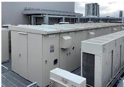
写真2 屋上の高圧受変電設備
