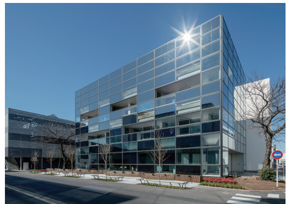
図6 技術センターに建設された『ZEB』
