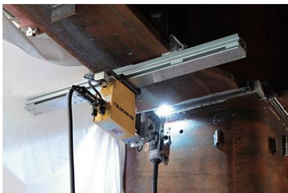
写真3 汎用可搬型溶接ロボット（上向き溶接）
