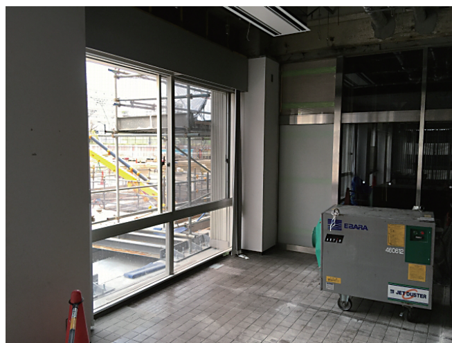
写真1 現場状況に応じた対策例 集塵機を使用して室内側空気を窓から外部へ排出
