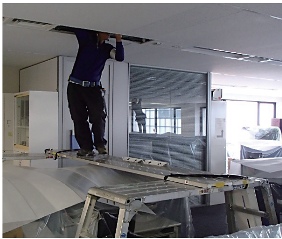
写真1 事務所改修時の養生例
