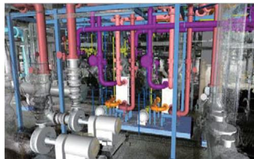
図7 既存配管・新設配管 融合モデル
