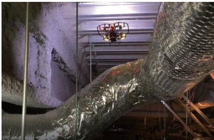
写真15 ドローンによる天井内調査
