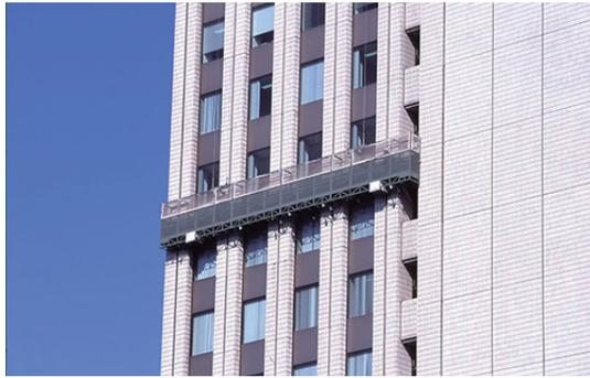
写真12 外壁改修用ゴンドラ
