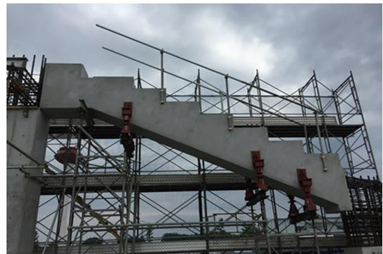
写真9 段梁支保工施工状況
