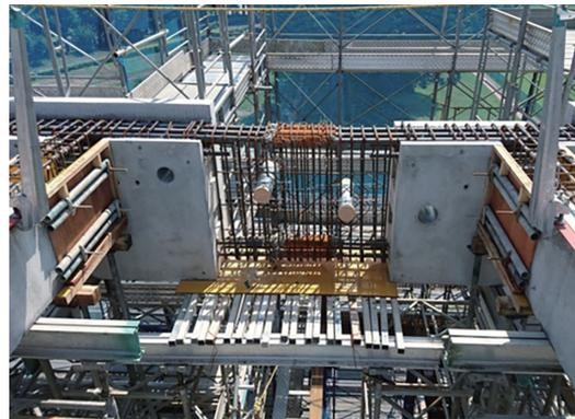
写真4 鉄筋嵌合状況
