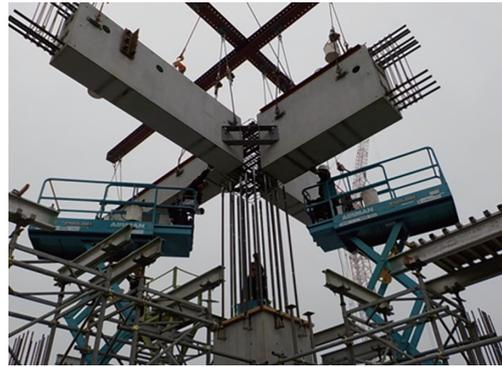
写真3 PCa梁取付状況
