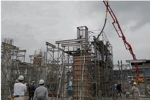
写真1 柱コン打設状況
