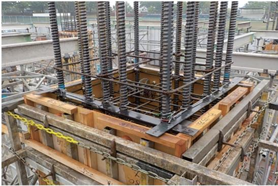
写真7 柱筋固定状況
