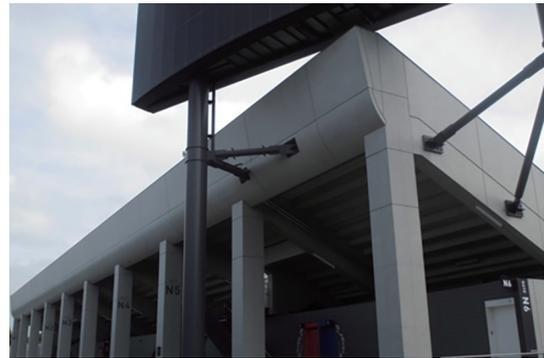
写真13 完成状況（曲面梁ほかPCa化）
