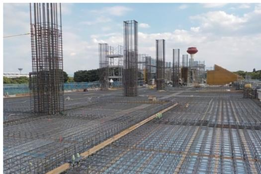
写真6 スラブ・柱配筋状況
