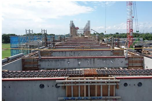
写真5 仕口部型枠状況
