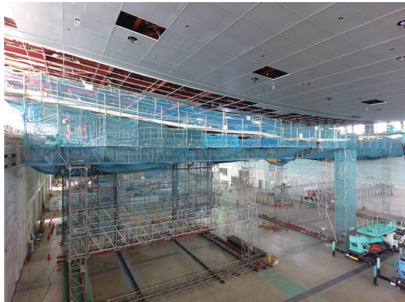
写真5 展示場「グランメッセ熊本」の施工状況
