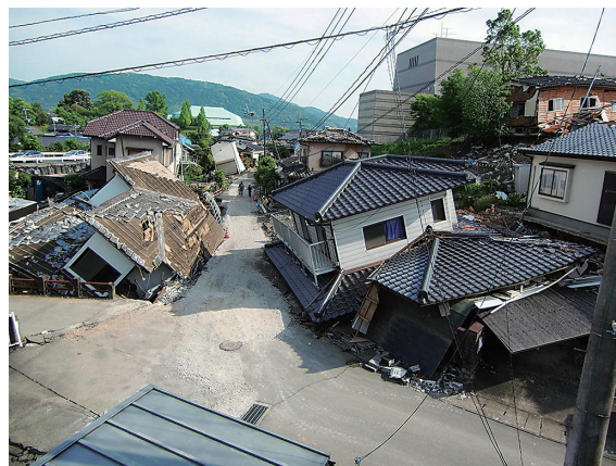
写真1 益城町の住宅被災状況
