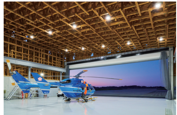
写真9 発災後に発注した県総合防災航空センター完成写真
