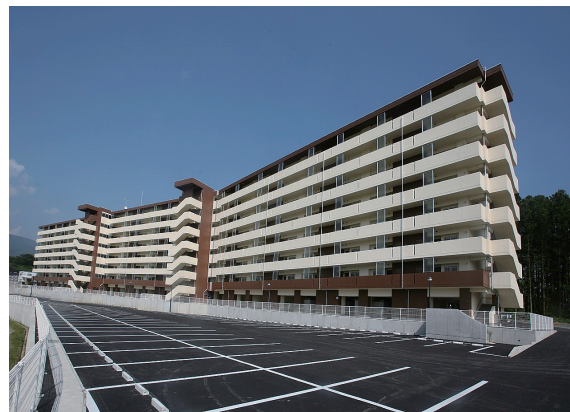
写真2 陸前高田市内の中田団地【H27.9完成、197戸】 （工区分けた建築工事において、入札不調が発生し、全体工程管理に困難をきたした）
