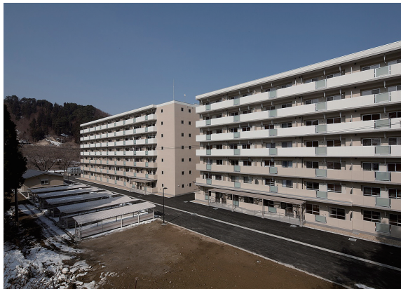
写真1 大規模な災害公営住宅としては、県内最初に完成した釜石市内の平田団地【H26.1完成、126戸】 （資材搬入が通常納期より大幅に遅れ、工程管理に困難をきたした）
