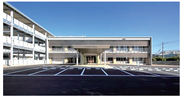
写真8 県立第二高校管理棟・図書館棟の建替え
